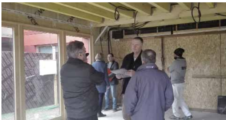
Les artisans, les élus et l'architecte à la réunion de chantier du 10 janvier
